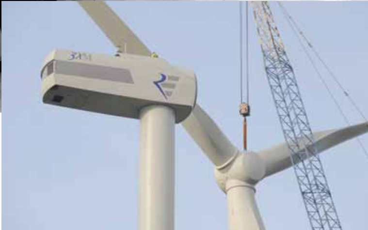
Montage einer Offshore-Windkraftanlage
